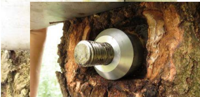
Abb. 6: Baumanker vor (links) und nach (rechts) der Verlängerungsmaßnahme
