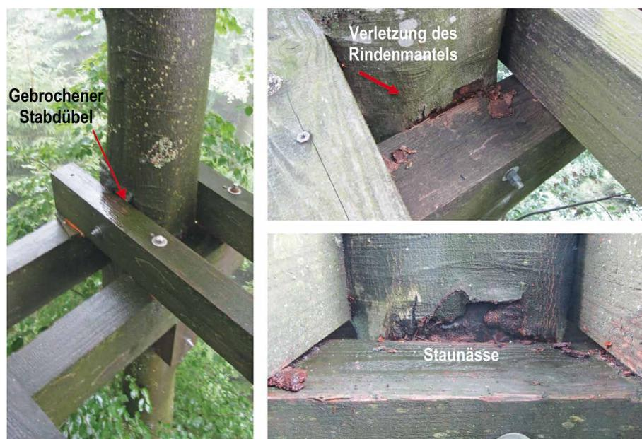
**Bild 1** Schadensmerkmale durch Befestigung mittels Balkenzange
