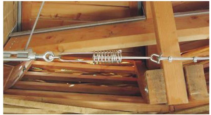
**Bild 10** Dämpfungsfeder mit Verformungsbegrenzung zwischen Plattform und Steg
