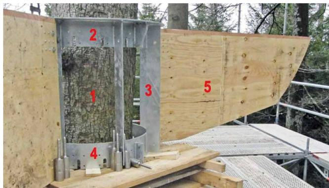
**Bild 12** Doppelte Umreifung, bestehend aus oberem Ring (2), Fahnenblech (3), unterem Ring (4) und Schwertscheiben (5)
