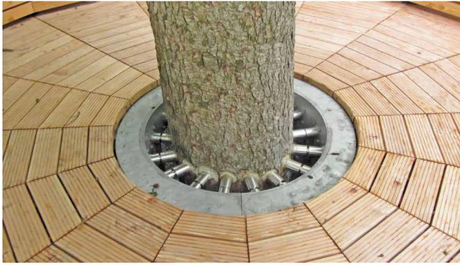
**Bild 14** Bodenbelag und doppelte Umreifung während einer Bauwerksprüfung; im Normalbetrieb schützen fest installierte, engmaschige Gitterroste den Bereich zwischen Umreifung und Baum
