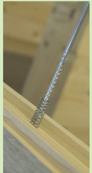
Abb. 5: Querschnitt der Blockbohlen sowie verschiedene Versuche zur Reduzierung des Schwind- und Quellverhaltens in vertikaler Richtung der Wand
