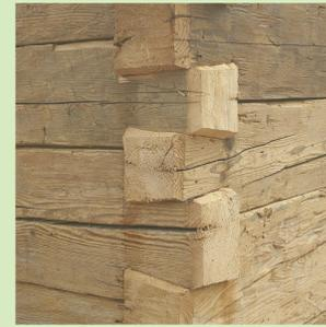
Abb. 1: Schwalbenschwanzverbindung aus [1]
