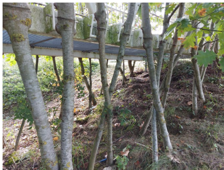
Junge Roteichen verwachsen untereinander und mit den Lagerpunkten des Stegs um ihn zu tragen
