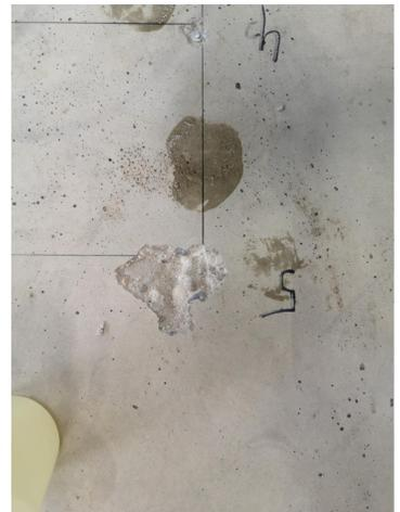
Abbildung 1: Abplatzung des Betons beim Einbringen von Befestigungsmitteln
